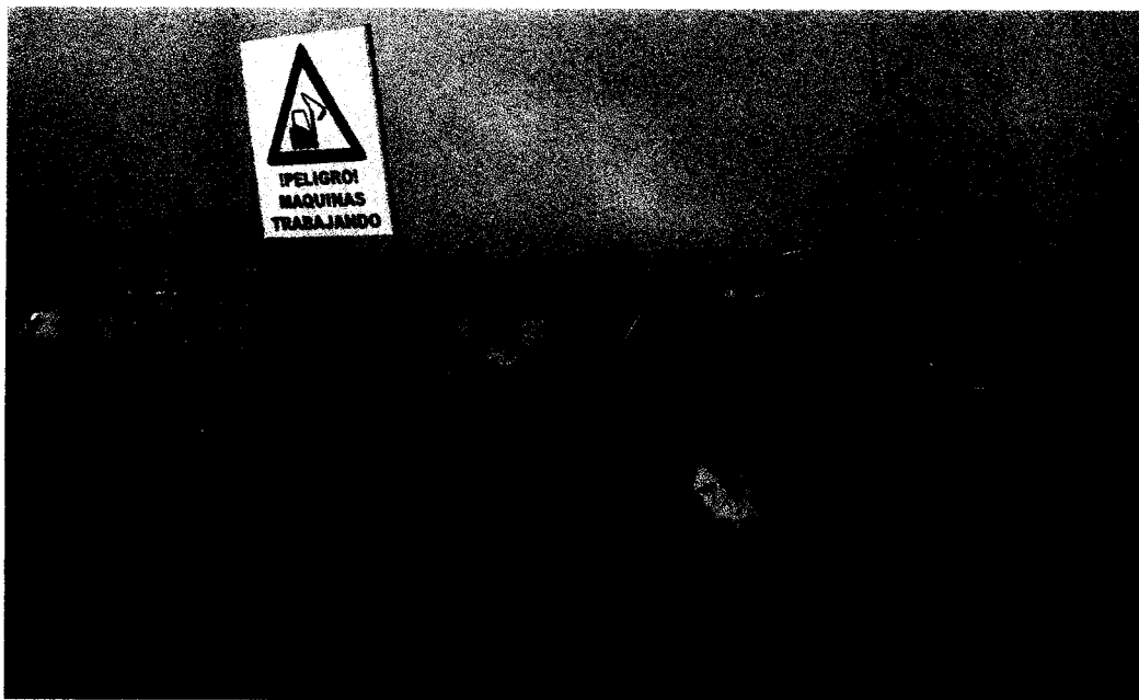
SEÑALIZACION ZONA ENROCADO
